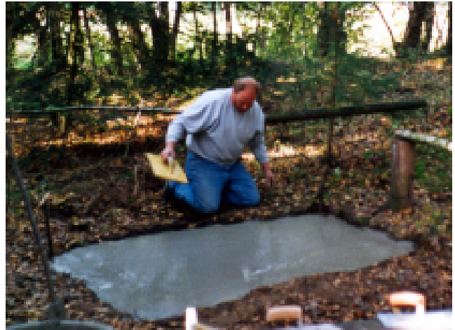
Hans glättet das Fundament im Herbst 2001
