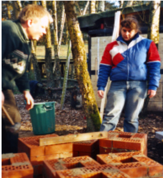
Markus und Britta mauern die Stützpfeiler!
